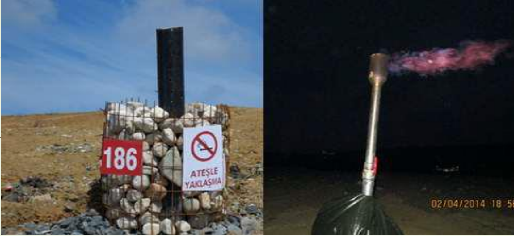
Resim 15: Gaz Toplama Bacası ve Meşale
