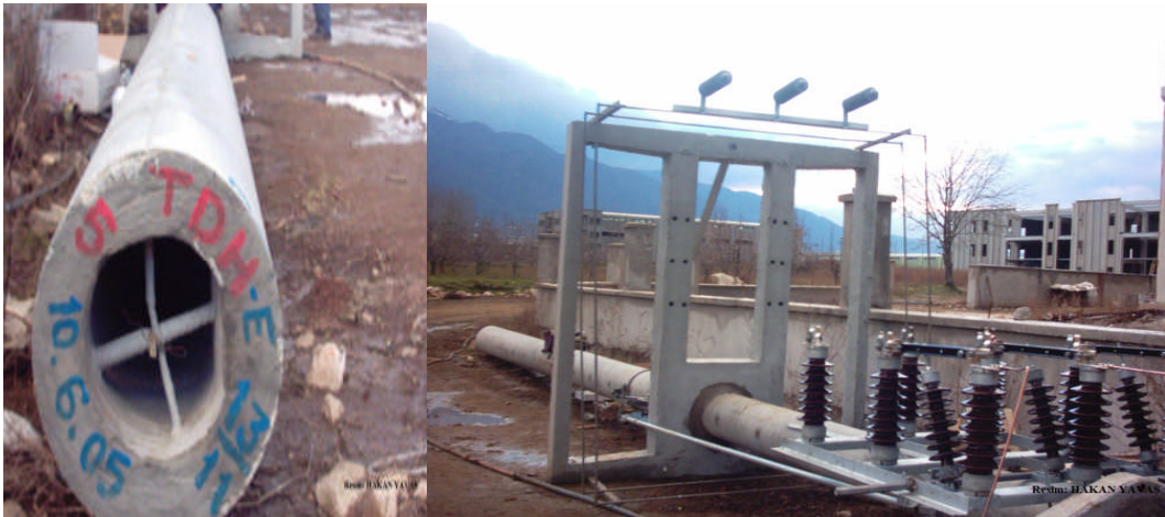
Resim 2.8: Santrifüj direk (SBA) ve beton trafo direği
