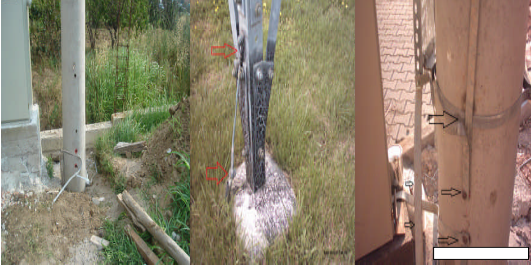
Resim 2.12: Beton direk topraklaması
