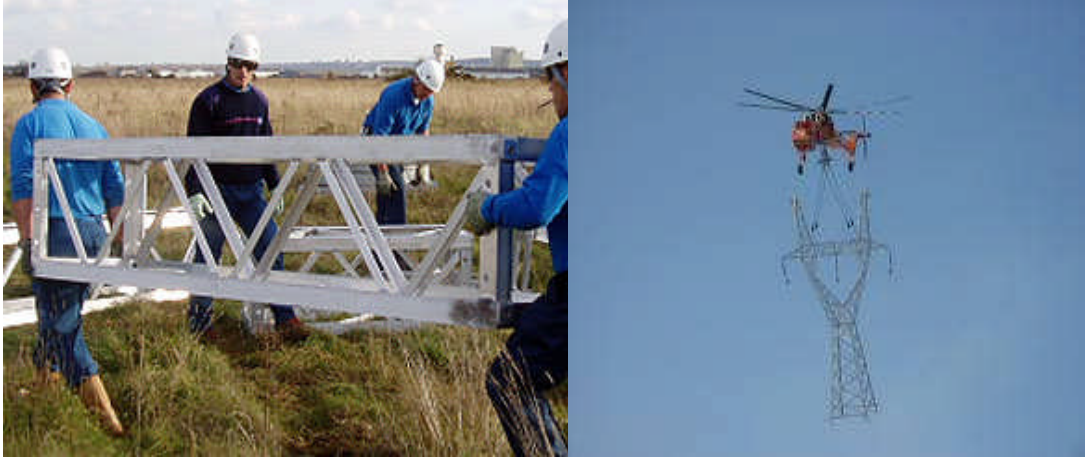
Resim 2.3: Demir direk montaj yerine getirilmesi
