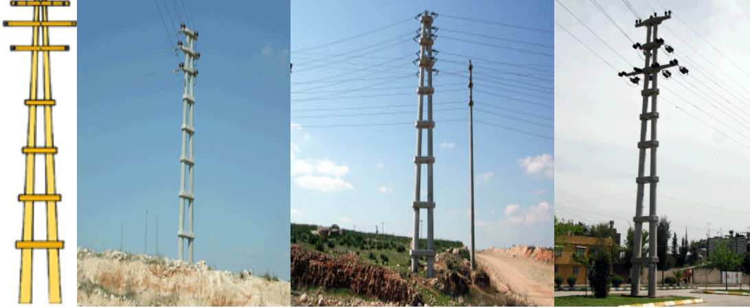
Resim 1.10: Çift santrifüj beton direkler
