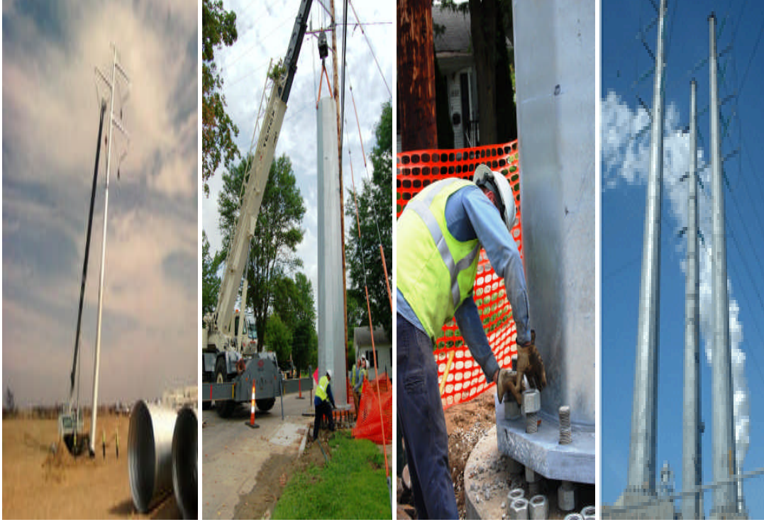
Resim 2.10: Demir-galvaniz direk montajı
