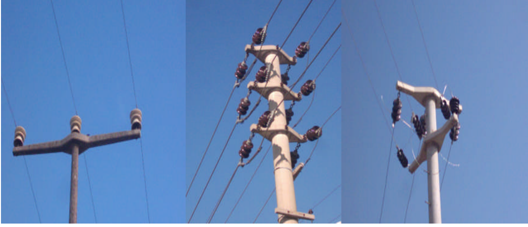
Resim 3.1: Direklerde beton traversler
