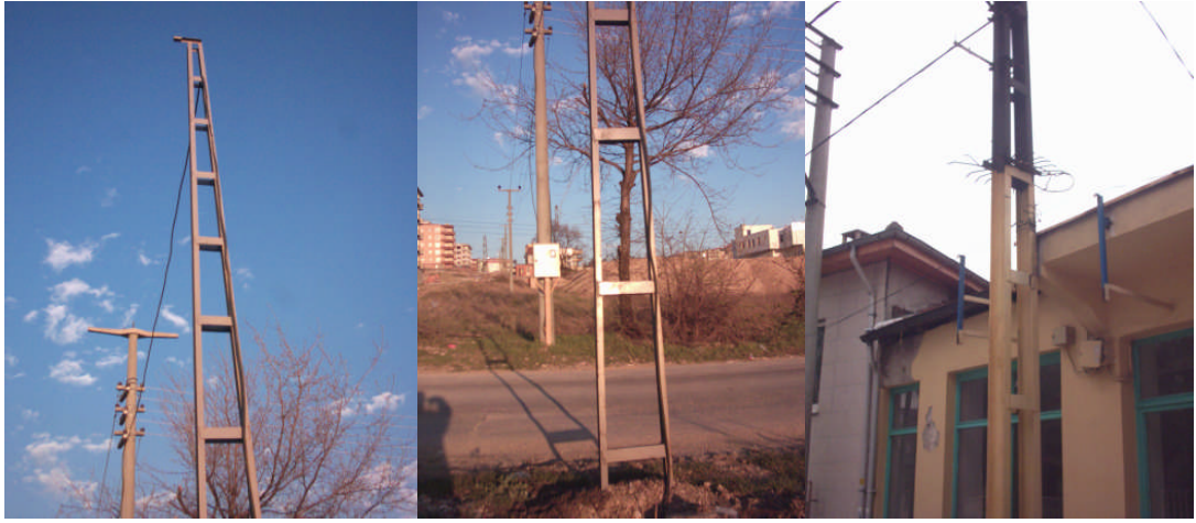
Resim 1.3: A tipi demir direkler
