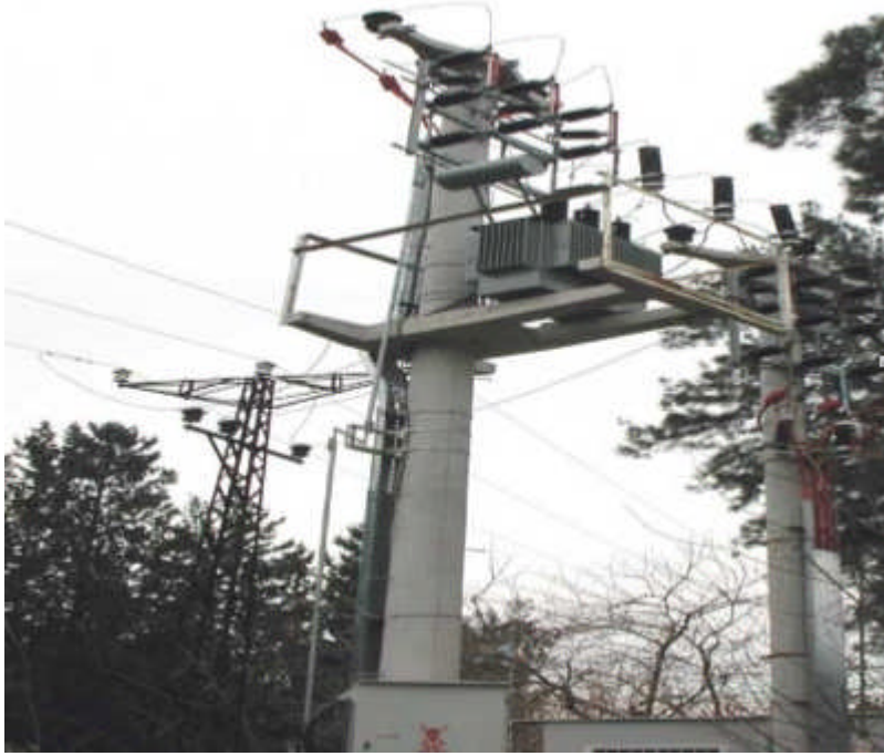
Resim 1.16: OG beton trafo diređi
