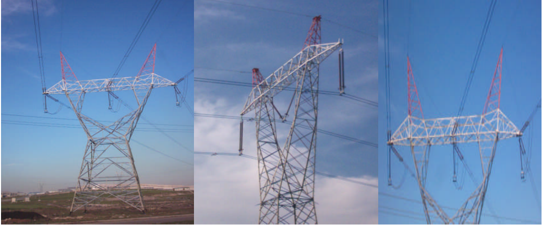
Resim 1.6: Çatal tipi demir direkler
