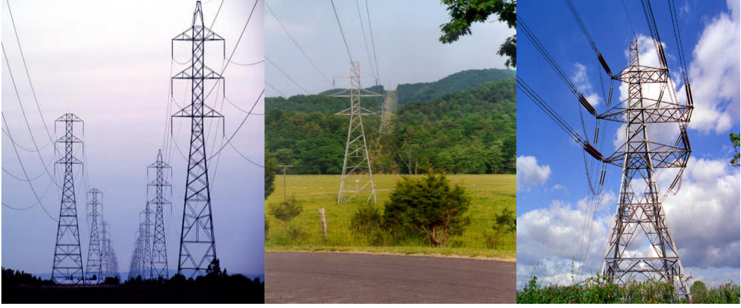
Resim 1.5: Pilon tipi demir direkler
