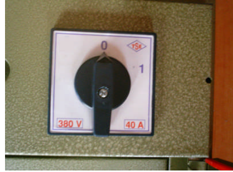
Resim 1.28: Montajın bitmiş hâli
