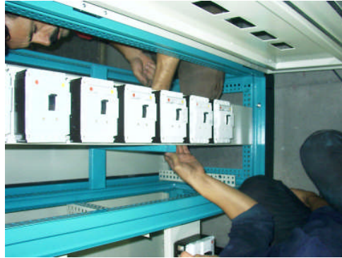
Resim 1.44: Montajın bitmiş hâli
