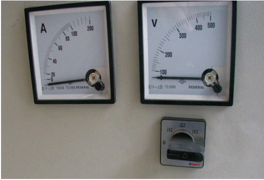
Resim 1.30: Voltmetre komütatörü montajlı hâli
