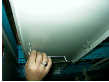
Resim 1.43: Şalterin arka bağlantıları
