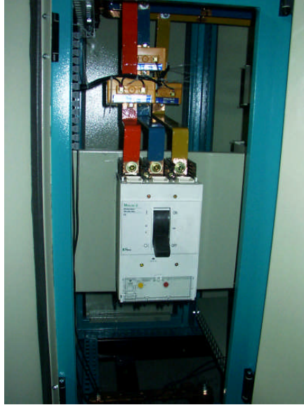
Resim 1.43: Kompakt řalter bađlantısı
