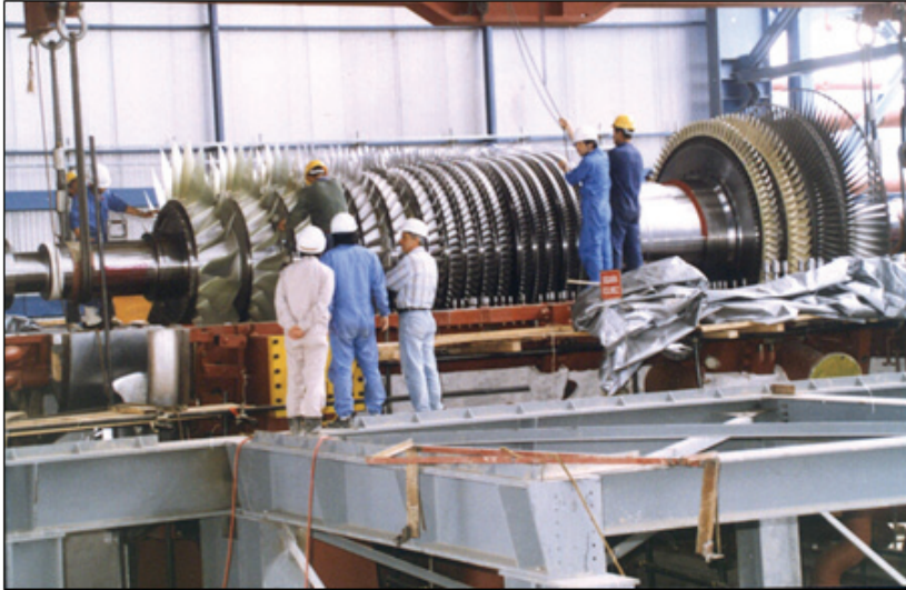
Resim 3.6 Bursa kombine çevrim santralinde gaz türbininin yerleştirilişi
