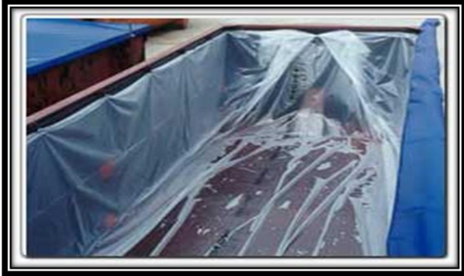
Resim 2.50: Konteyner zeminine naylon türü destekleyici malzeme serilmesi
