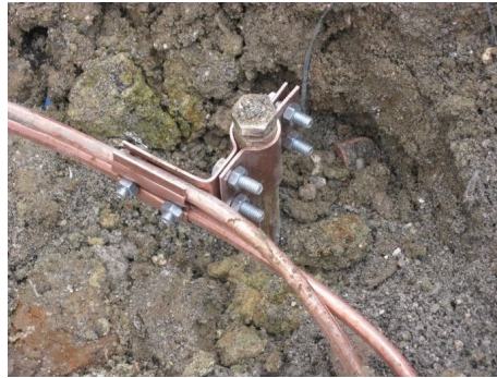
Resim 12.21. Topraklama çubuğu ve topraklama hattı
