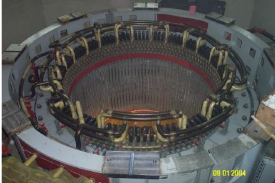
Bir senkron generatörün statoru
