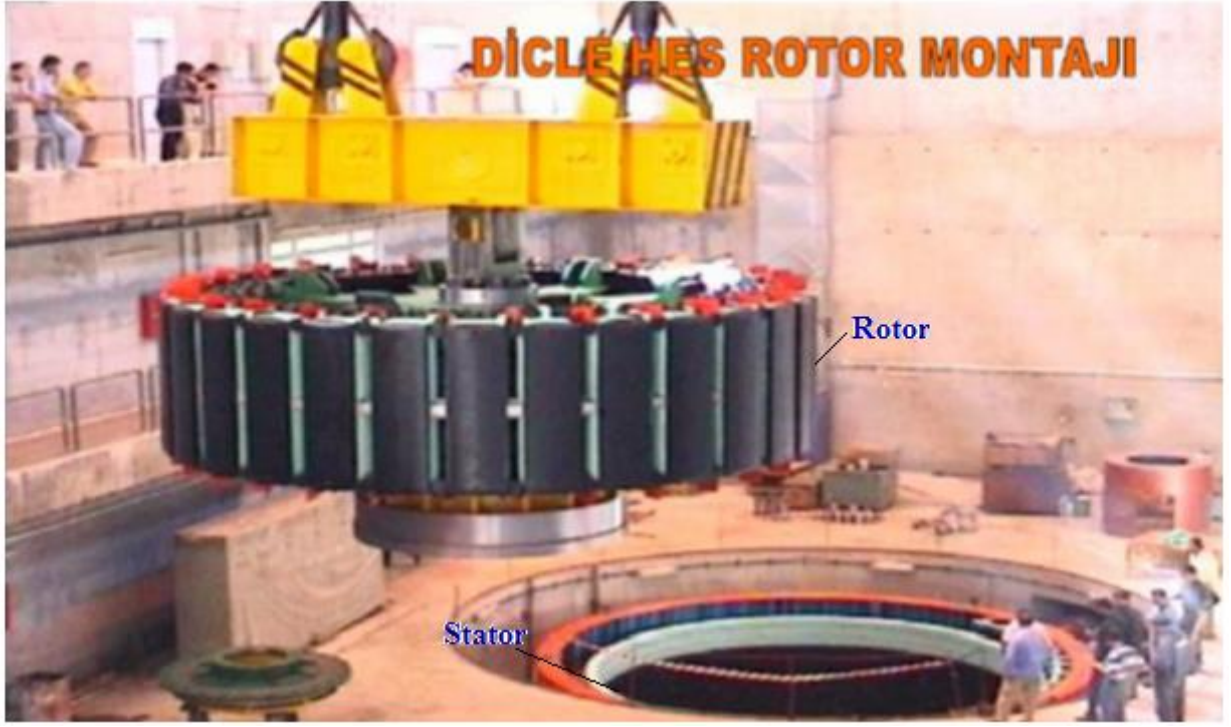
Bir elektrik santralinde montaj esnasında rotorun görünümü
