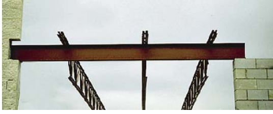
Şekil 4.6: Kayar ve Sabit Mesnet'in Birlikte Uygulanması
