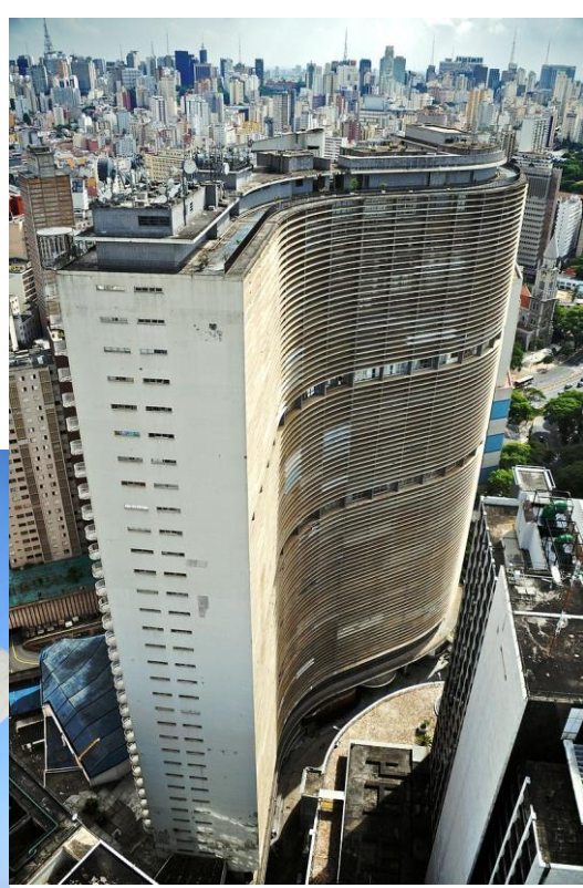
Copan Apartman Kompleksi Brezilya. 1953-1966
