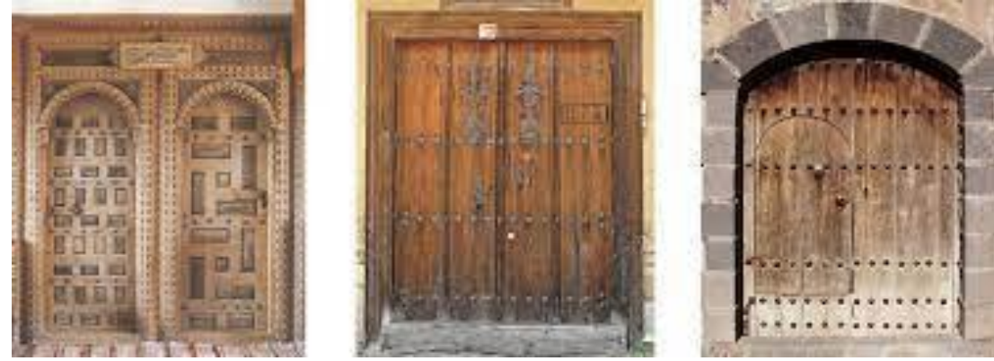
Geleneksel Türk Evi'nde oda kapısı, dış kapı ve kuzulu kapı
