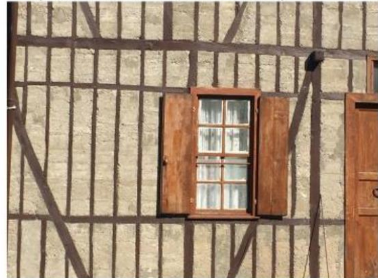
● Ahşap doğrama detayı (sonradan müdahale ile)
