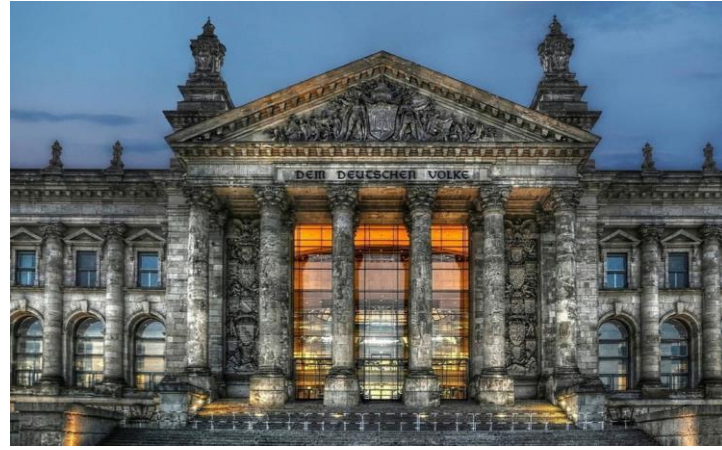
Almanyada Reystag binası.
