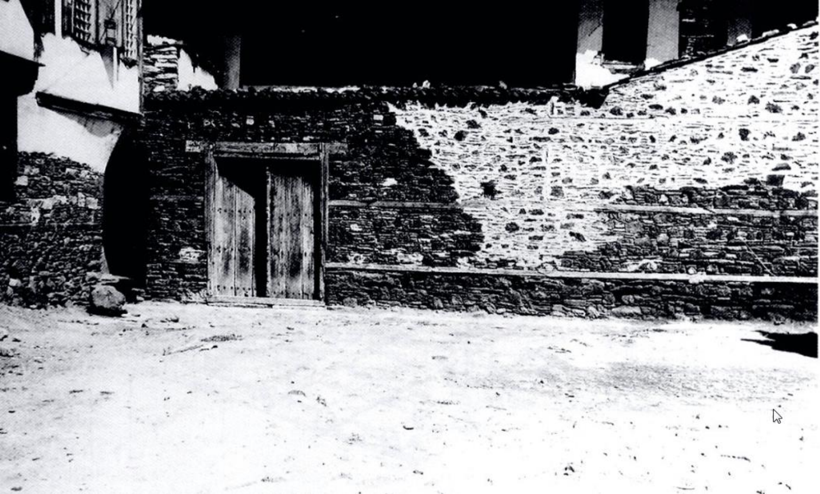
Resim 2: Kula'nın Kaçıklar Evi'nin karakteristik Ege bölgesi moloz taş duvar dokulu avlu duvarı
