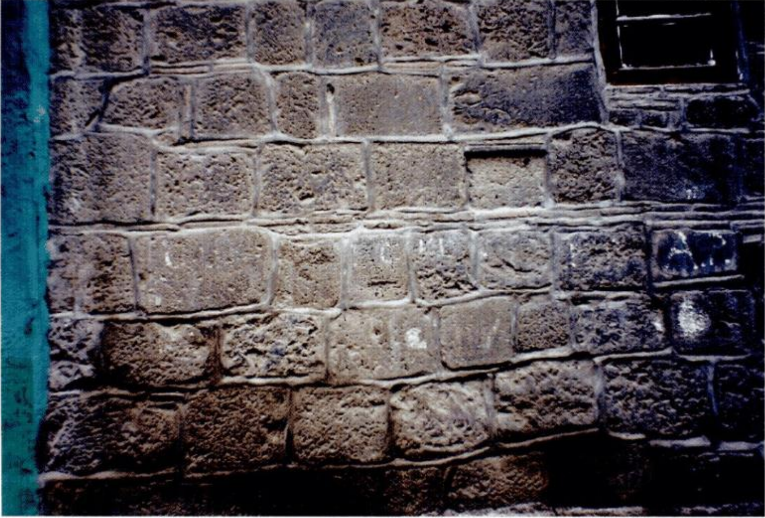
Resim 64: Mescidin kaba yonu siyah trakit duvar dokusunun yakından görünümü (1999)
