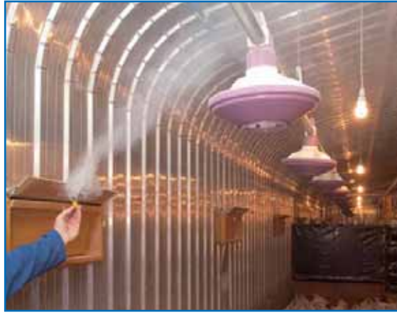
Şekil 107: Hava klapelerine takılan hava yönlendiriciler
