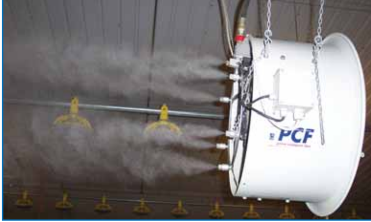
Şekil 14: Cıvciv bölmesinde sisleme cihazları kullanılarak nemin artırılması
