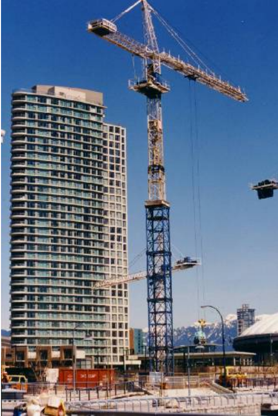
Şekil 4.12: Vinç'te denge sistemi
